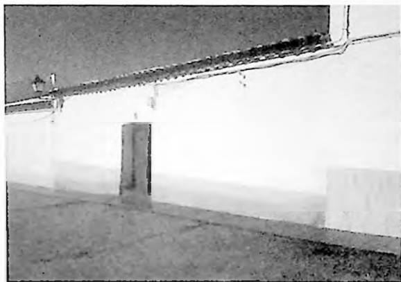
Fachada de la casa colada popular.
