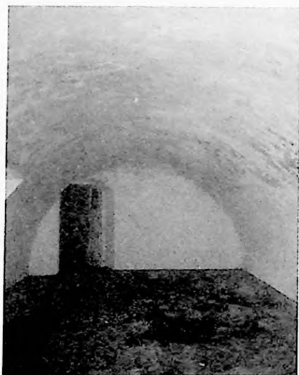
Bóveda de cañón bajo el graderio de la Plaza de Toros.
