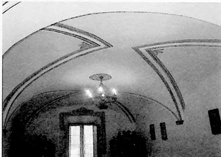
Bóvedas de crucería o pañoletas. Siglo XVII.
