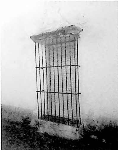
Ventana con enrejado tradicional de forja con poyo y guardapolvo. C/. Virgen del Soterraño.
