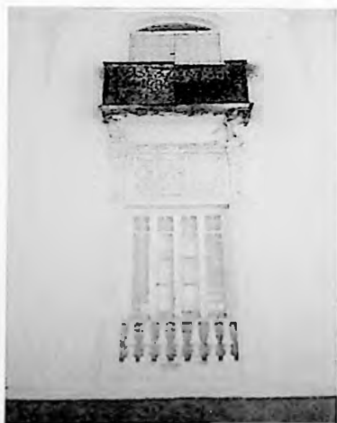
Detalle de la "Torre" lateral derecha del palacete de la calle Jerez.
