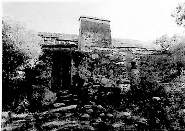
*Fachada principal del molino que mira hacia aguas abajo. Puede verse la puerta de entrada, el saliente del hogar donde se haría lumbre y que se prolonga hacia arriba en la chimenea, y en la parte de abajo, a la derecha de ese saliente, la salida del cárcavo.*
