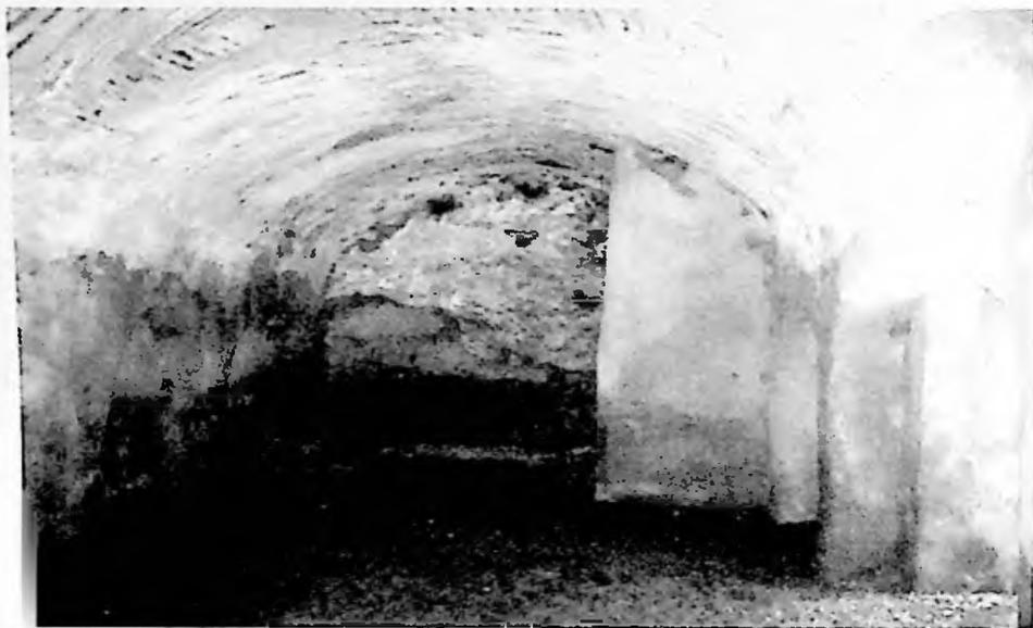
*Interior de la sala de molienda. Al fondo a la derecha se aprecia cómo el muro final del cubo se introduce en la sala.*
