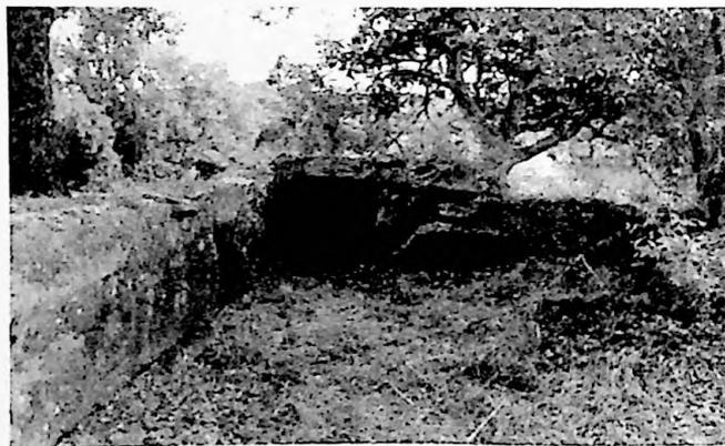
*Llegada del canal a la rampa cubierta por la que el agua descendía hacia el cárcavo.*
