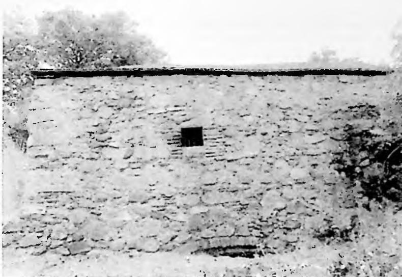
*Pared de la sala de molienda situada junto al arroyo. Se aprecia en la parte inferior el arco de ladrillo bajo el que el agua salía del cárcavo.*
