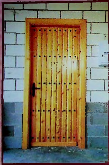
Puerta en el interior de los talleres, fabricada por los alumnos de ebanistería en pino flandes, barnizada al natural y con los herrajes en negro. Estilo lameada
