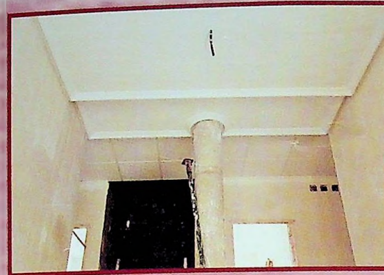
Techo de escayola fija a distintos niveles, rematada con molduras
