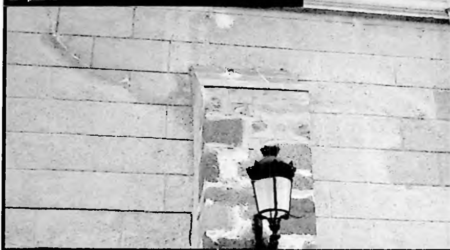
Detalle de cómo están quedando los contrafuertes rematados con pizarra
