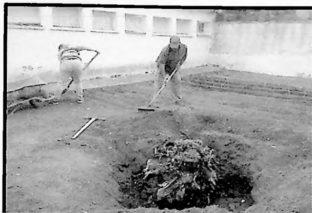
En 2014 se iniciaron las labores de acondicionamiento y puesta en marcha del huerto ubicado en las instalaciones de Infantil del colegio
