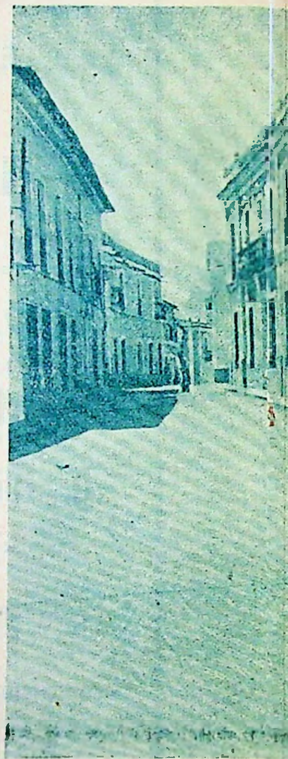
Vista de la calle HERNANDO DE SOTO
