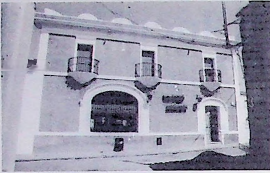
Fachada Hogar del Pensionista
