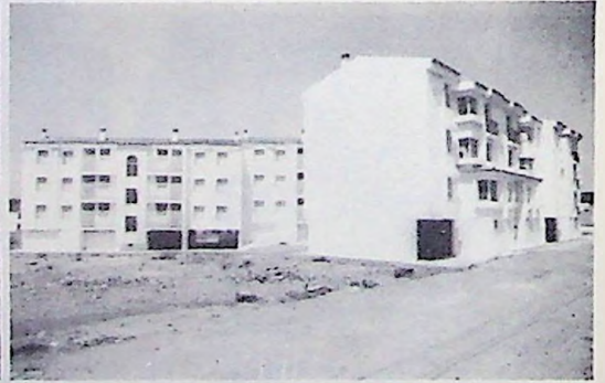
Nuevo grupo de las 25 viviendas
